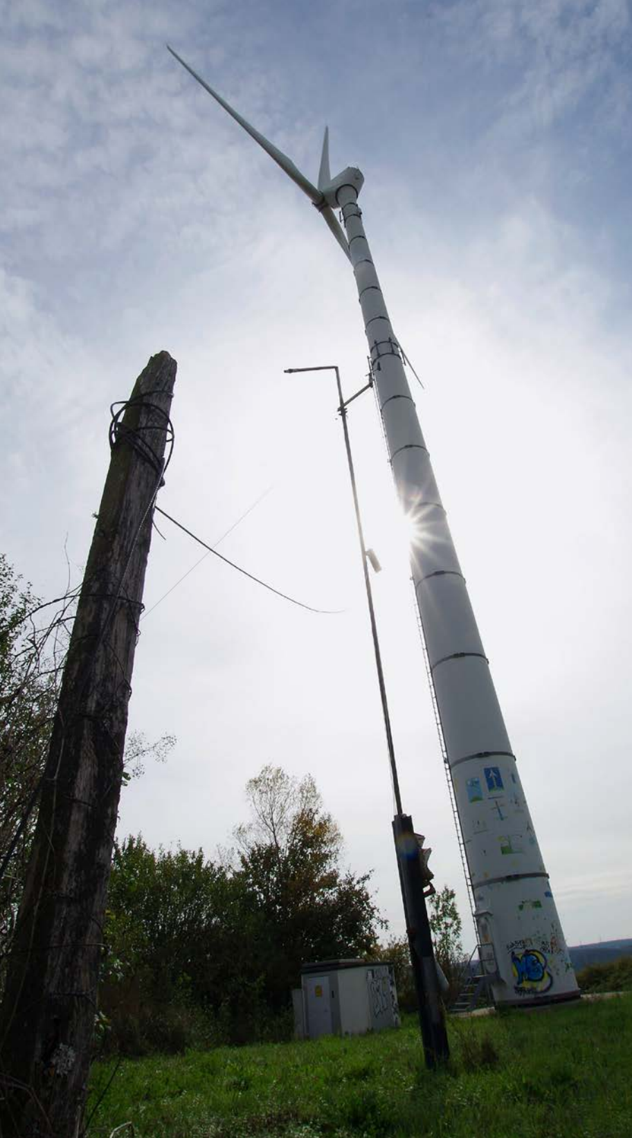
Das Bürgerwindrad Vogtsreichenbach wird wohl nach 2021 abgebaut werden – ein Ersatz ist nicht genehmigungsfähig
