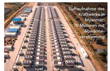
Luftaufnahme des Kraftwerks in Myanmar: 70 Motoren mit Abwärmeverstromung
