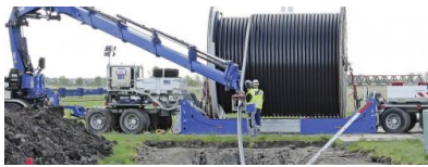
Erdkabelverlegung für das Gleichstromprojekt Nordlink. Quelle: Tennet
